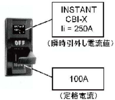
図 0-6 瞬時引外し電流値と 定格電流の表示例
